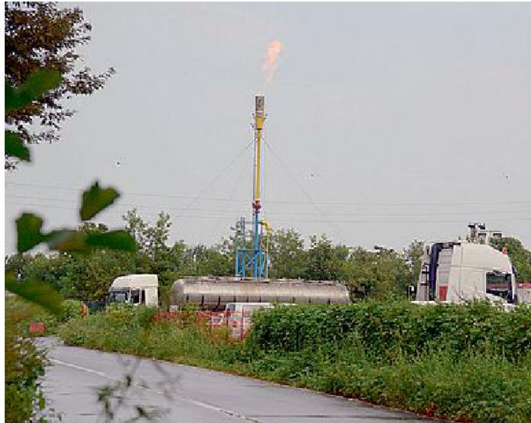
CANTIERE Lo spurgo di un pozzo al Cluster B a Cornegliano (Cavalleri)
